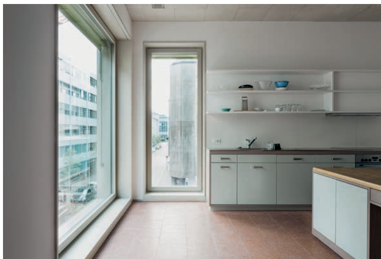
Sichtbetondecken und Kunststeinböden widerstehen dem Studententreiben, Öffnungen in der Brandwand erlauben den Blick in die Tiefe der Zürcher Militärstrasse.
