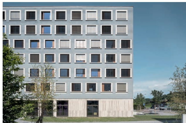
Versetzte Fenster mit Putzlaibungen und Betonfensterbänken überspielen die immer gleichen Studentenzimmer zur Hofseite.
