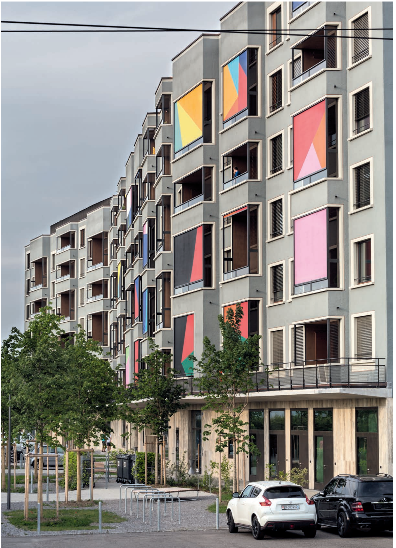
«Kampf gegen den Hasenstall-Effekt»: Risalite aus überhohen Loggien mit farbenfrohen Storen der Künstlerin Shirana Shabazi gliedern das Studentenwohnhaus in Zürich-Affoltern.
