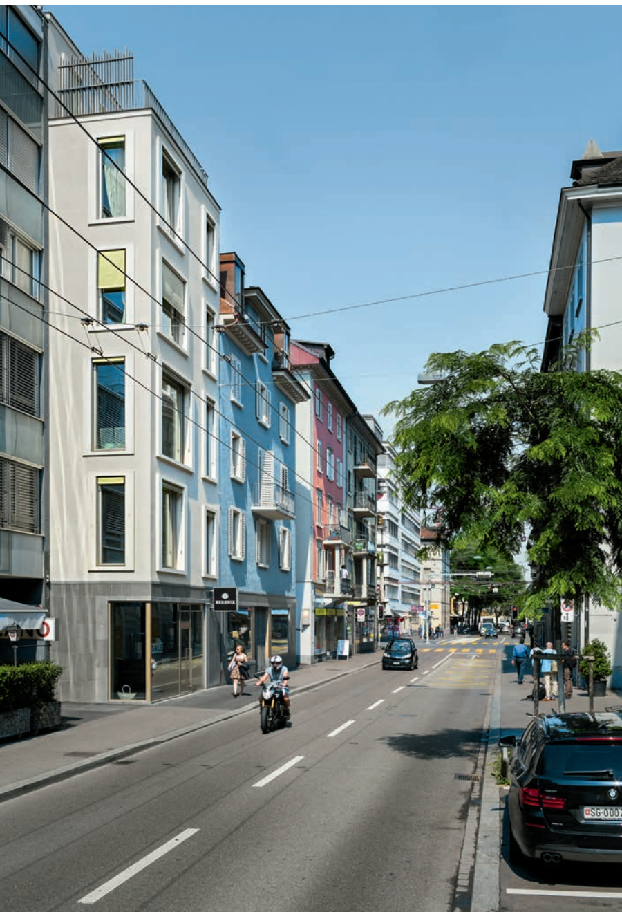
Im weiss verputzten Anbau weichen grosse und frei angeordnete Fenster die Regeln des graublauen Bestands auf, der durchgehende Basaltsockel verwischt die Grenze.
